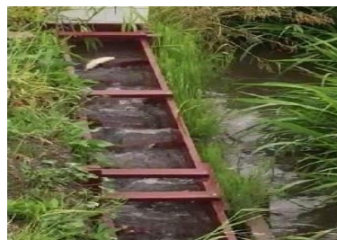
排水路に作った魚道
