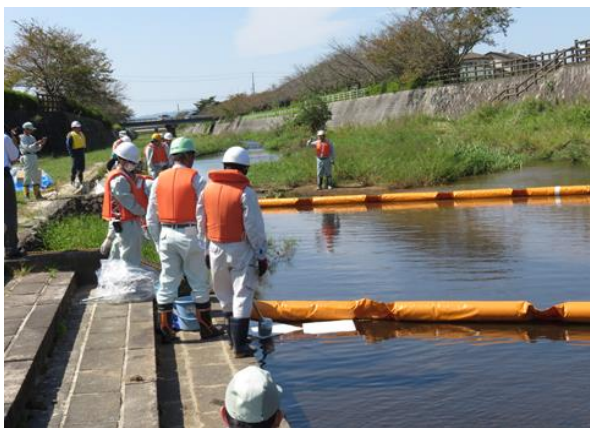
オイルフェンス展張
