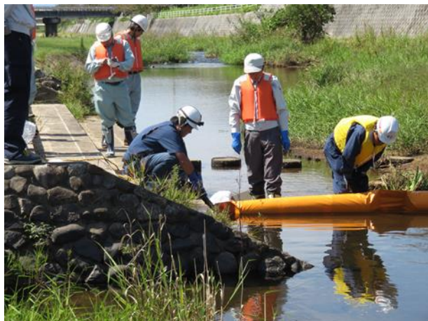
吸引車でオイル吸引
