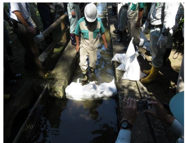
水路での土嚢積みによる堰止め
