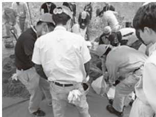
①土嚢作り
