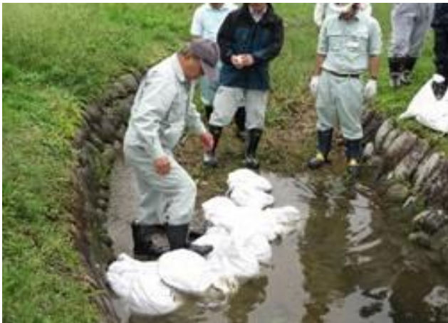
パイプを用いて土嚢底部の水路確保
