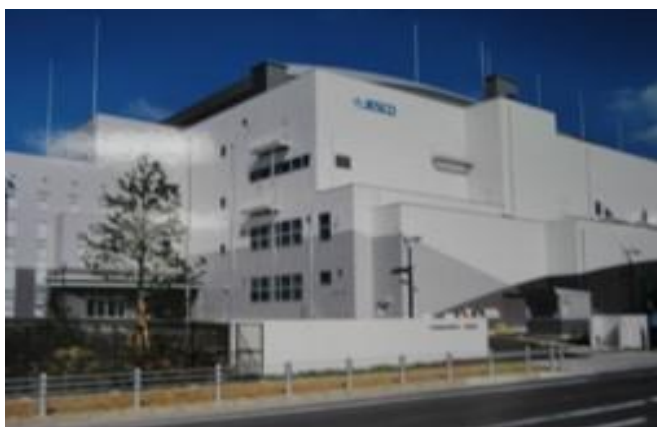
（大阪 PCB 廃棄物処理施設）
